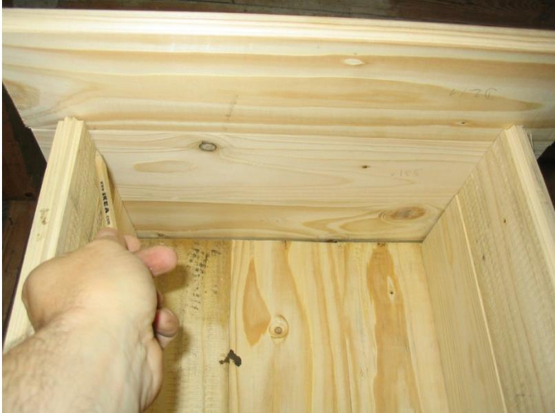
Wenn jetzt die Markierungen am Dach allzu schief sind, können sie noch korrigiert werden. Außerhalb der Markierung wird wieder vorgebohrt. Dann kommt das Dach wieder auf das Haus und wird verschraubt. Am einfachsten fängt man mit einer Vorderkante an, dann die andere Vorderkante (jetzt eventuell die rechten Winkel korrigieren), zuletzt die Rückseite verschrauben.
